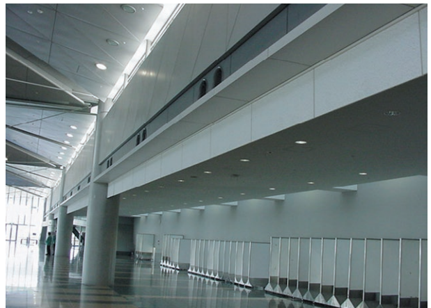
▲防煙垂れ壁可動時
